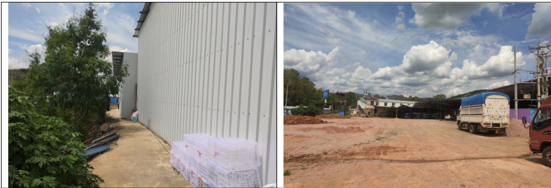
厂区西侧现状
